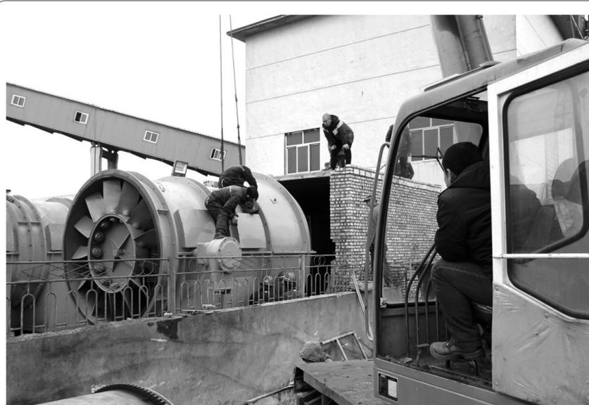
近日,澄合董东煤业公司对井下供风系统进行全面升级改造。通过本次改造之后,风量将大幅度提升,确保了井下各个作业现场有充足的新鲜风流,保证了井下工作人员正常作业。据悉,本次升级改造不仅在风机切换及应急操作上更加简便、流畅,电能节约方面更为显著,每年可为矿井节约电费20余万元。苟尚伟 摄
