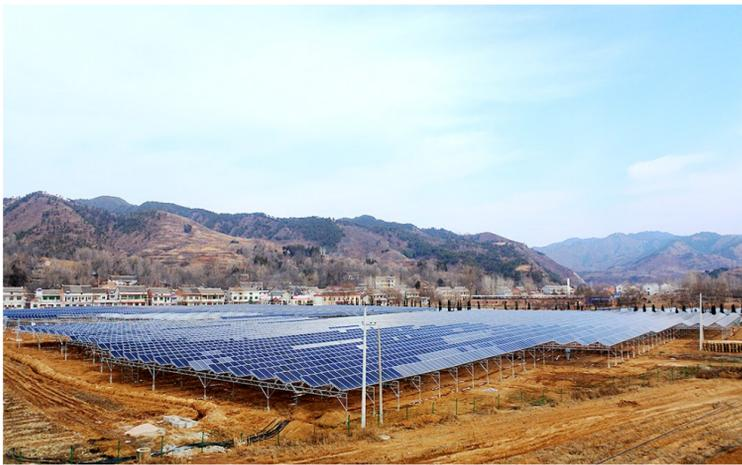
近日,洛南20兆瓦光伏扶贫电站全部并网发电。特别是新建的4个联村光伏扶贫电站,通过技术创新,将组件支架抬高到4米以上,支架桩距跨度拓宽到10米,满足农作物75%光照,便于在光伏场区发展高效农业,同时可吸纳贫困劳动力到光伏农场务工,从而实现“光伏+农业+就业”叠加收益,实现绿色生态环保循环经济的发展。
