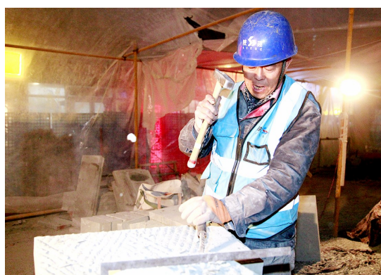
隆冬时节,陕建集团总承包的延安城市“双修”一期项目正千得火热朝天。由陕建八建集团负责施工的延安城市二道街环境整治项目40余名工人和管理人员,在零下十几度的施工环境中,现场采取架设柴油加热器、搭设施工暖棚、保温棉覆盖等冬季施工措施,连续奋战二十多个日夜,铺设了沿街1600平方米的石材。图为工匠师傅聚精会神地雕刻石材。
