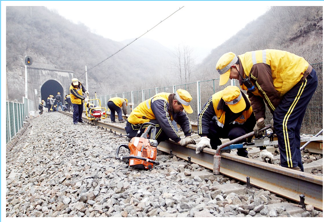
↑春运临近,中国铁路西安局集团有限公司阎良工务段计划利用5个施工天窗完成对梅七线13条侧磨钢轨的更换任务,全面消除薄弱环节设备隐患,为春运期间安全运输提供设备保障。图为干部职工在更换钢轨作业。 通讯员 速建飞 摄
