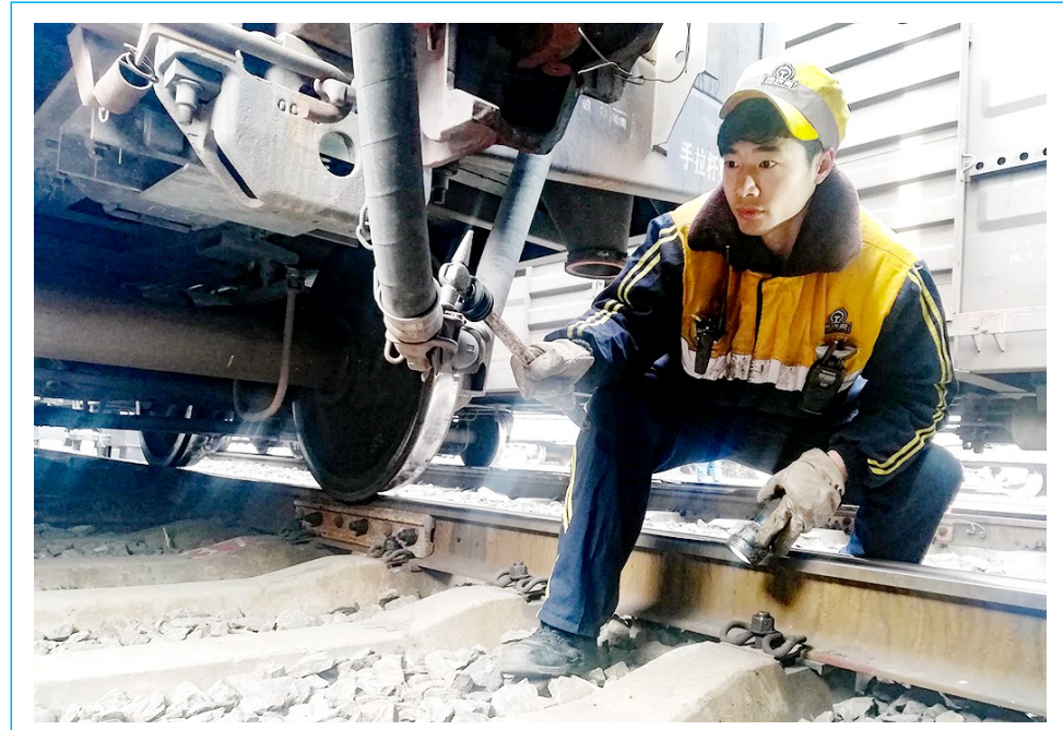
入冬后,铁路车辆制动管系故障多发,中国铁路西安动车段针对季节性易发故障入手,加大日常作业风管路回检、管系漏泄故障应急处置、制动
