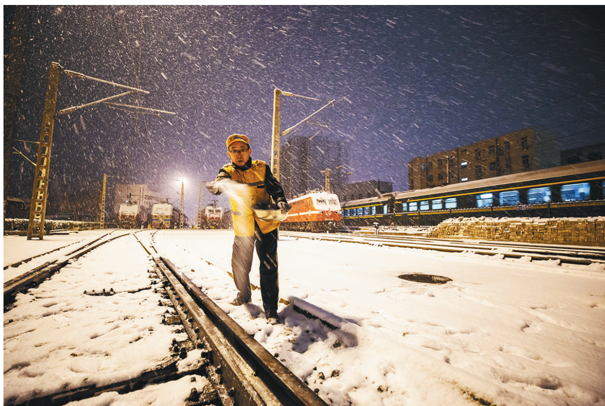
2月10日凌晨,在中国铁路西安局集团有限公司西安机务段机车整备场,作业人员在风雪中向钢轨重点部位撒融雪剂。刘翔 摄
