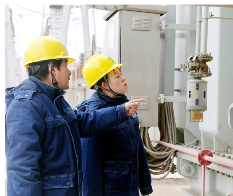
2月9日,铜川供电公司330千伏桃曲变电站值班员加强设备巡视,仔细检查主变设备温度及油位等,保证春节供电安全可靠。 □通讯员 井丽君 摄
