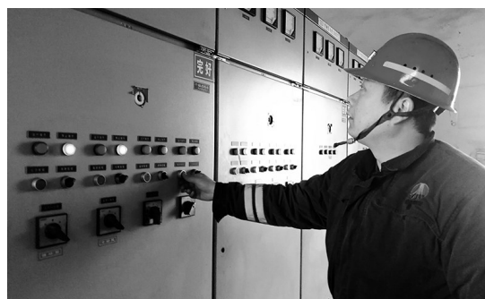
陕北矿业韩家湾煤炭公司在复工复产的第一天，由生产部、安环部、机电部等职能部门人员组成了安全检查小组，对地面和井下各生产岗位进行“拉网式”安全大检查。艾锋 摄
