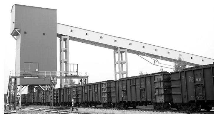
近日,陕北矿业红柳林公司快速装车站在中国铁路西安局集团有限公司延安车务段被评为“标准化专用线”。田宏伟 梁永博 杭鑫 摄
