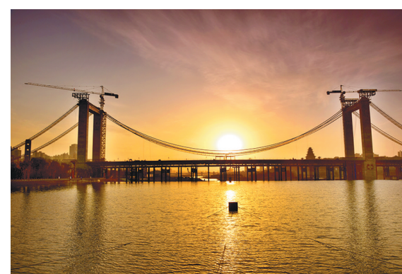
近日，宝鸡联盟渭河大桥主桥主体实现贯通。该桥全长1390米，主桥共由41个钢箱梁节段组成，总重4700多吨，主桥为空间双索面自锚式悬索桥，采用欧式风格混凝土桥塔，是渭河陕西段同类桥梁中跨度最大的悬索桥，预计6月底通车。图为3月31日，宝鸡联盟渭河大桥晨曦雄姿。
