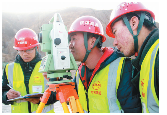
4月1日,中铁二十局市政公司陕津高速公路项目部新员工(右)在跟班学习测量实务。该公司以建设具有“品质铁建”特质的工程公司为主线,采取“现场授课+岗位练兵+鼓励创新+绩效挂钩”的方式,强化“导师带徒”培养力度,促使青年员工快速成长为业务骨干和创新能手,为企业高质量发展强筋壮骨。 □许岗 摄
