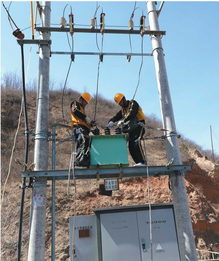
连日来,中国铁路西安局集团有限公司绥德供电段抓住春季设备检修的黄金时机,强化设备整治,确保设备运行。图为该段职工在检修变压器引线线夹。 谭永良 摄
