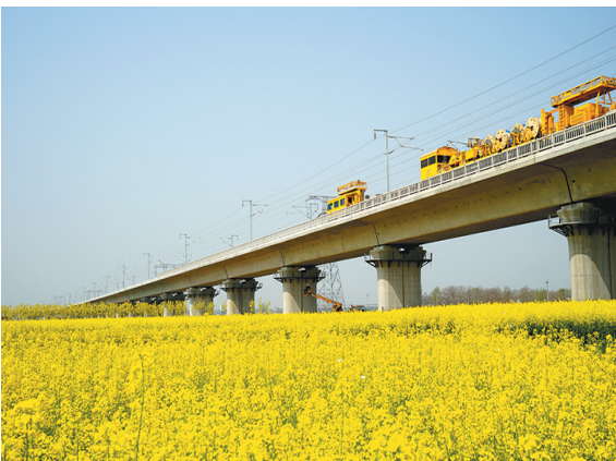
新建的郑州至万州铁路途经河南、湖北、重庆三省市,是国家十二五规划的重要客运专线。中国中铁七局集团三公司承担着该段3标颍河特大桥10公里桥梁下构、4处连续梁、661片箱梁的制架及10公里无砟轨道施工任务。截至4月7日,该公司负责的各项主体施工已全部完成
