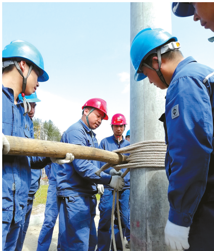
为切实提升员工业务技能水平,强化安全生产责任意识,近日,岚皋县供电公司组织开展各供电所配网综合岗位员工
