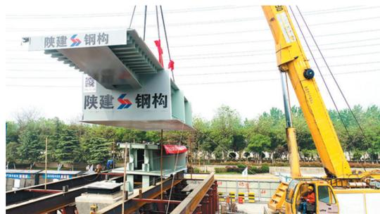
4月11日上午,一块长14米,高1.8米,重达35吨的钢梁在130吨汽车吊牵引下,稳稳地落在胎架预定位置。陕建朱宏
