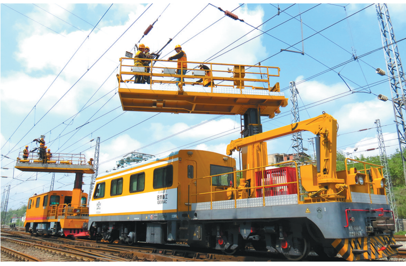
“五一”小长假临近,中国铁路西安局集团有限公司安康供电段精心备战假期铁路运输,采取“2+2”(两台作业车+两台梯车)作业模式,提前对重点区段、关键设备进行精检细修,全力确保小长假期间供电设备运行安全。图为4月22日,该段职工在安康车站检修分段绝缘器。向金虎 王成 摄
