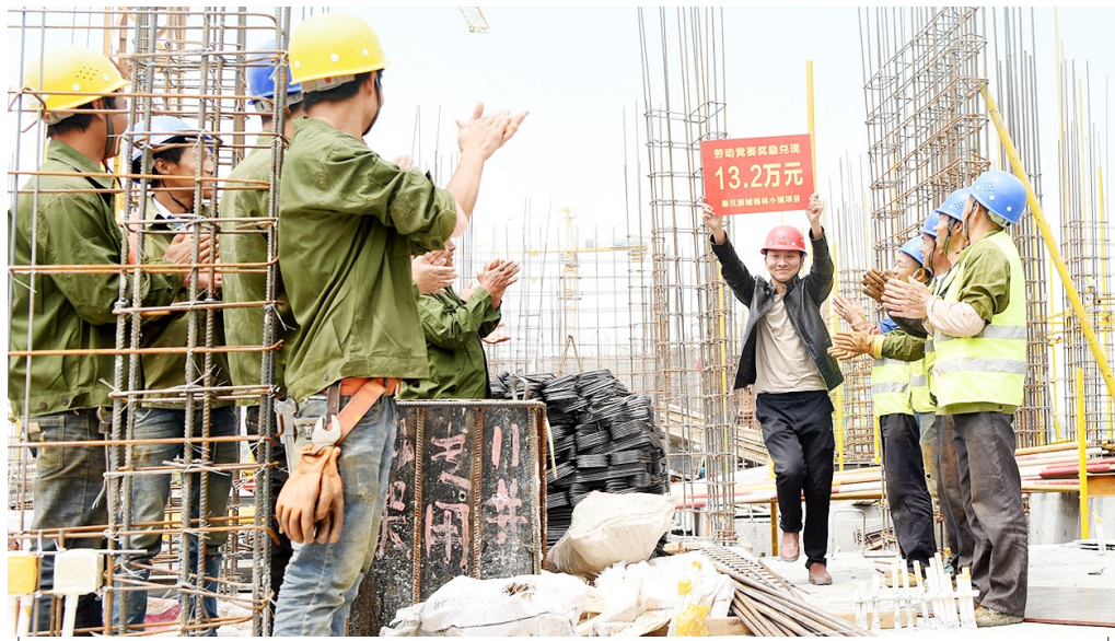
4月27日,在由中建一建公司承建的西安秦新城格林小镇一期项目建设工地,陕西金昌劳务公司项目经理举牌与工友分享获得劳动竞赛奖励的喜悦。 本报记者 刘强 摄
