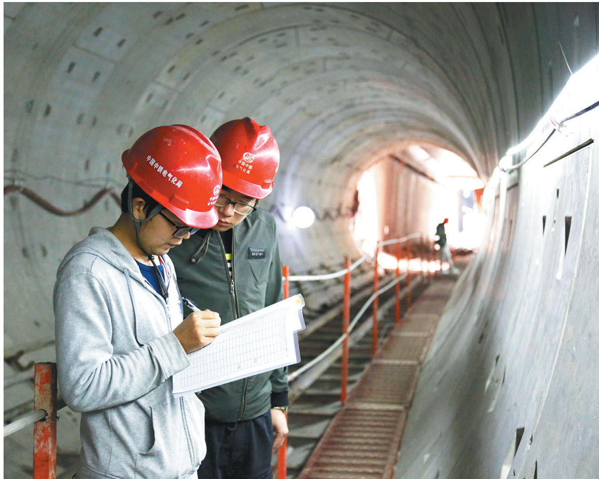
5月1日,中铁电气化局的众多建设者坚守在工作岗位上,在劳动中度过节日。在西安地铁5号线高新四路至劳动南路区间隧道工地, 中铁电气化局铁路工程公司的项目管理人员在对成型隧道盾构施工质量进行定期检查。 倪树斌 摄
