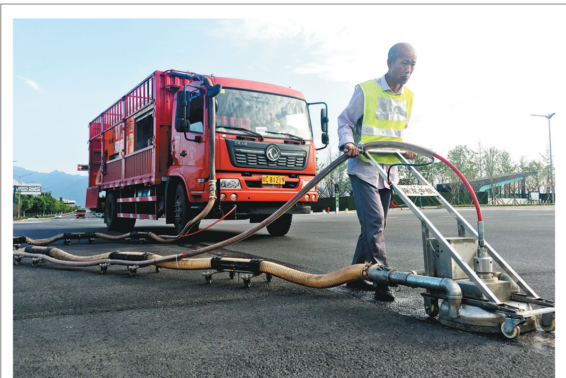
5月16日下午,西安路中交通设施有限公司的施工人员试用高压水流喷射去除道路标线的新技术。该项技术是利用高压旋转喷头清除道路上已画好的标线,再用高压回吸管把清洗下来的渣水吸回到车内回收箱中。 □王忠义 摄
