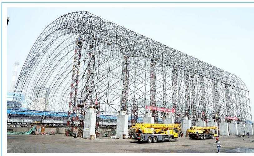
5月17日,陕西韩城龙门煤化工备煤车间(煤棚)封闭工程A区134米跨度球型网架安全合龙。该工程由中国能建西北电建四公司承建,是西北跨度最大的煤棚,长度为176米。胡文革 摄
