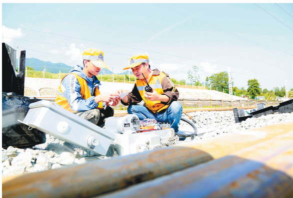
近日,经过中国铁路西安局集团有限公司安康电务段以及相关单位4个多小时联劳协作,阳安二线新设涇池铺站施工顺利完成并开通。图为施工结束后,职工运用微机监测系统对全站设备进行不间断调看分析。 □王建涌 摄
