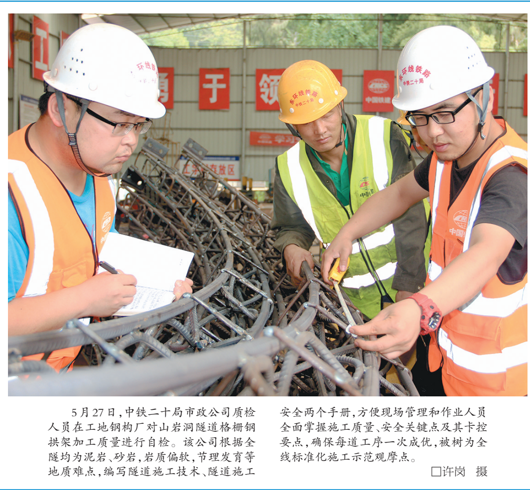
5月27日，中铁二十局市政公司质检人员在工地钢构厂对山岩洞隧道格栅钢拱架加工质量进行自检。该公司根据全隧均为泥岩、砂岩，岩质偏软，节理发育等地质难点，编写隧道施工技术、隧道施工
