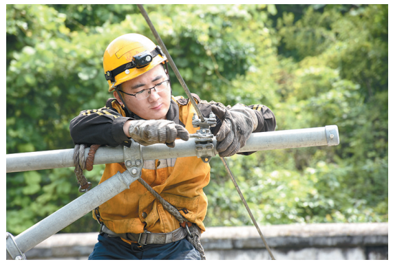
近日,中国铁路西安局集团有限公司安康供电段组织人员拉网式巡视排查接触网、电力杆塔、拉线状态等关键设施、部位,认真梳理存在问题,按照轻重缓急迅速进行整治,保证汛期供电安全稳定。段增旗 摄
