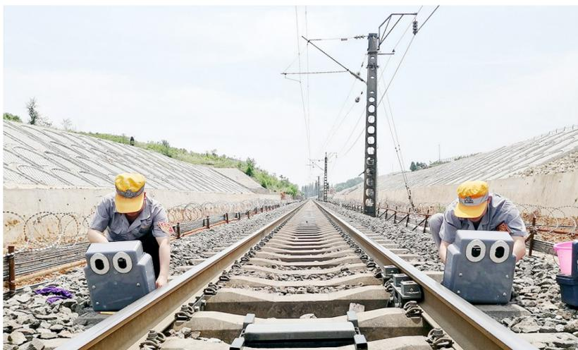
连日来,陕西南部持续高温,中国铁路西安局集团有限公司安康车辆段加强对轨边“5T”车辆监测设备的检查,防止设备死机、探测不准等季节性故障发生,以优质服务为车辆安全运行提供保障。图为该段动态监测设备车间职工在检修THDS设备。 周道刚 摄
