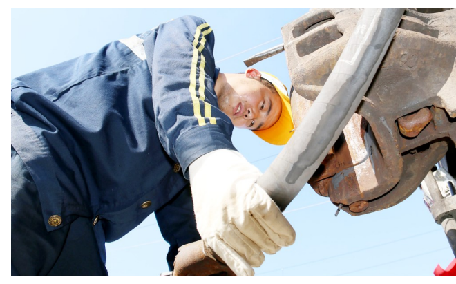
与此同时,针对高温情况下接触网容易发生断线、线索卡滞、抽脱的实际情况,该段进一步细化完善抢修应急预案、明晰处置流程,积极开展演练,不断提升快速抢修能力,确保暑期供电安全平稳。
