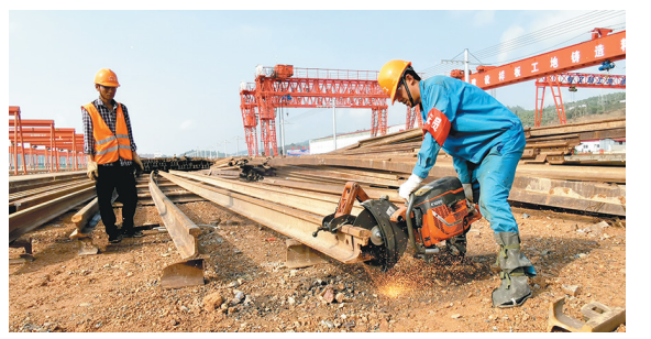
近日,中铁一局新运公司在玉溪研和铺架基地建设,开展“遵章守纪,勿忘安全,严格操作规程,做好自我保护,落实防范措施”主题活动,保证施工生产顺利进行。图为员工穿戴好安全防护用品在切割钢轨作业。刘顺良 摄
