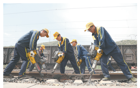
铁路物流集团红柠铁路公司职工在养护铁路。
