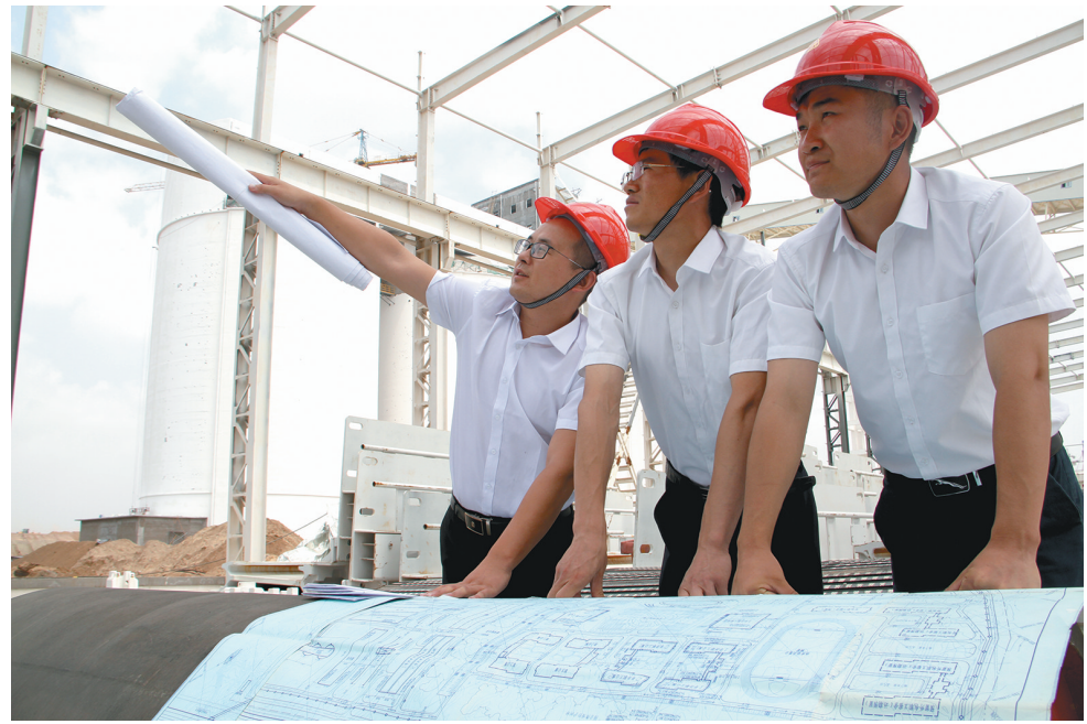
工程技术人员奋战在陕北矿井建设现场。
