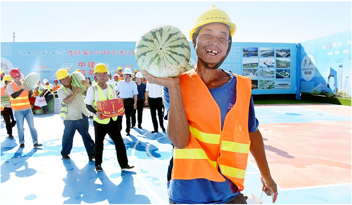
虽然已经立秋但骄阳依然火热,8月14日,省建设工程组织人员到中国建筑西安地铁十四号线体育中心站项目,为一线工人送去工会的关怀和防暑降温品。 据了解,该项目将在地下贯穿渭河 400 多米河道,为目前西安地铁地下贯穿渭河最长标段。同时也是 中国建筑在西北地铁建设市场的首个大标段、综合性施工总承包项目。 本报记者 刘强 摄
