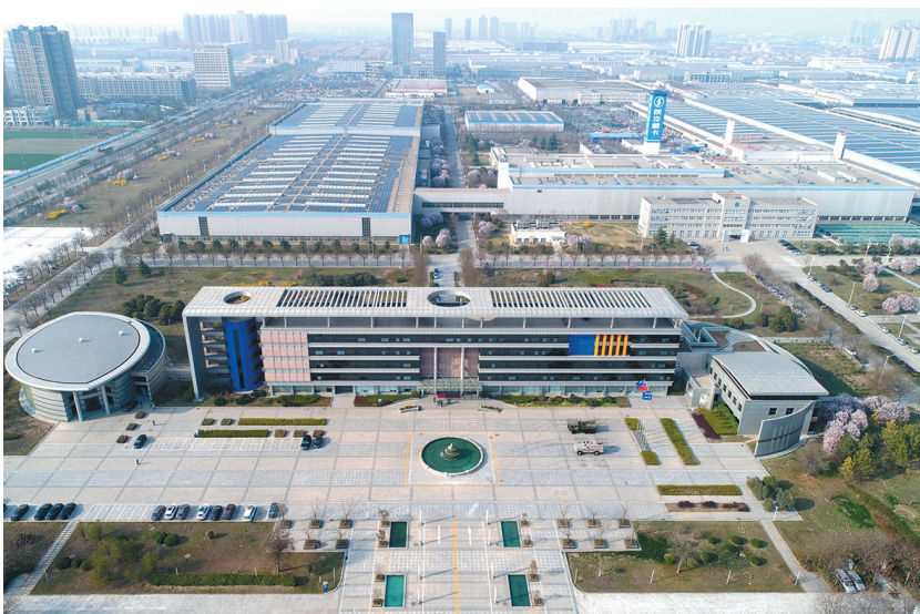
图为2018年3月15日无人机拍摄的陕汽商用车产业园
