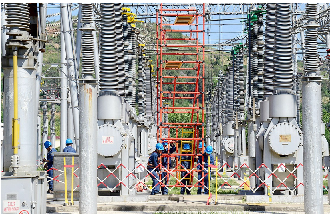
9月9日,国网商洛供电公司变电检修中心利用秋检之机,对张村330千伏变电站二号主变间隔开关、避雷器、互感器除锈刷漆,防止电力设备锈蚀,确保安全可靠供电。
