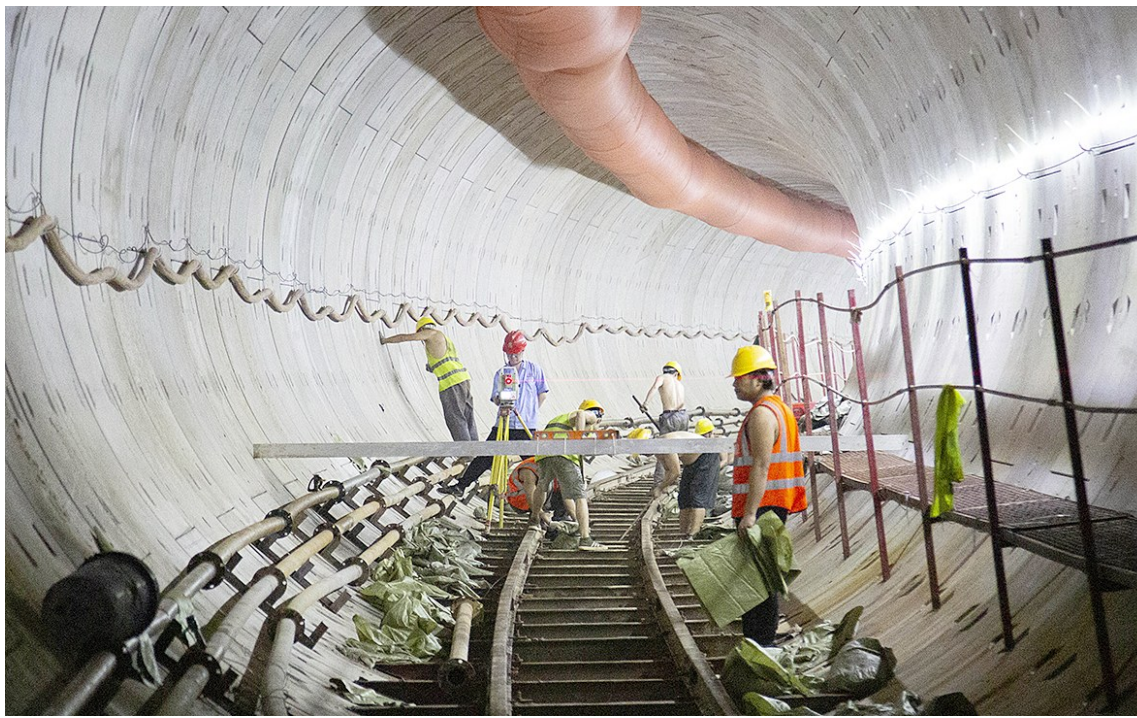
9月15日,在西安地铁5号线隧道工地,中铁电气化局铁路工程公司员工正在进行施工和测量作业。为确保工期,中铁电气化局铁路工程公司员工仍坚守工地,加快西安地铁5号线建设,为早日铺轨创造条件。 倪树斌 摄
