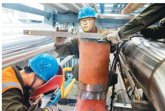
近日,陕建安集团四公司承建的合肥彩虹G8.5+液晶基板玻璃建设项目提前两个月实现产线点火,获得业主单位的好评。图为合肥彩虹项目焊接蒸汽管道。 □王诗萌 薛军 摄
