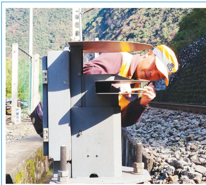
近日,中国铁路西安局集团有限公司汉中工务段为确保防洪防汛工作持续稳定,启用人员防控和技防“双保险”,为防洪安全持续稳定提供有力保障。图为该段职工正在完成检修异物侵限防灾报警设备。 周俊英 摄
