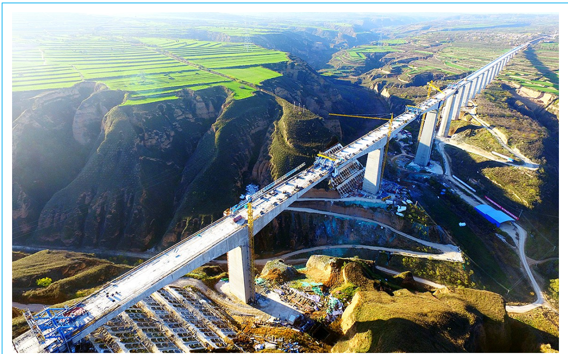
11月9日，随着最后一方混凝土顺利浇筑，西银高铁全线跨度最大、桥墩最高的漠谷河2号特大桥合龙。
