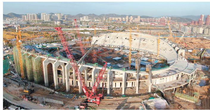
由中建三建集团承建的延安全民健身运动中心工程投资13亿元,计划于12月30日前完成体育场和体育馆屋面钢结构工程与砌体工程。 刘祥胜 胡玉龙 摄
