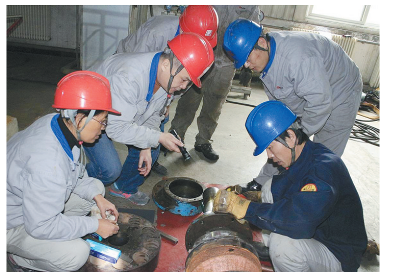
11月12日零时,大唐宝鸡热电厂提前三天实现向宝鸡市供热,出口温度等主要参数达到国家供热标准,拉开了新供热季的大幕。今年以来,该厂为了更好地履行央企供热责任,在提高热网运行可靠性、挖掘供热潜力、服务用户等方面积极努力,确保市民温暖过冬。图为职工在更换热网循环泵轴承。 孙剑波 摄
