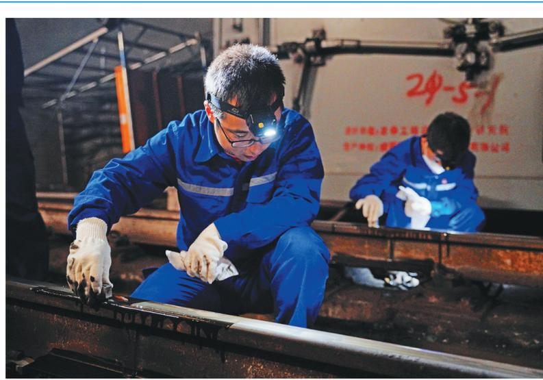
近日,西安市轨道交通集团运营分公司运营一中心工建一分部紧抓防寒过冬工作,确保地铁钢轨设备在冬季寒冷天气下状态良好、安全稳定。图为轨道探伤工班检修人员在对钢轨焊缝接头进行伤损探测。 □李嘉彬 摄
