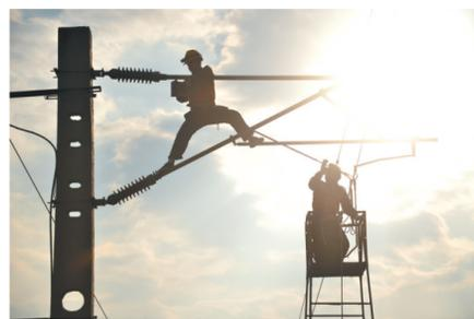
针对近期天气逐渐转寒、早晚温差较大、接触网供电设备参数极易因天气变化而产生变化的实际,中国铁路西安局集团有限公司西安供电段利用天窗时间,对接触网设备进行排查检修,消除供电安全隐患。
