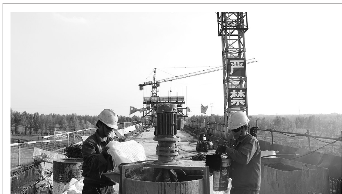
目前,建设集团路桥分公司统筹安排,提前规划,落实冬季施工方案,做好物资采购和设备管理工作,并针对关键部位和关键工艺环节制定专项措施,加强技术管控和质量检查,确保冬季施工质量和安全。图为该公司工人正在靖神铁路JTJ-04标段(即辅助线,孟家湾至红石峡段)高家伙场特大桥施工现场进行预应力管道压浆作业。
