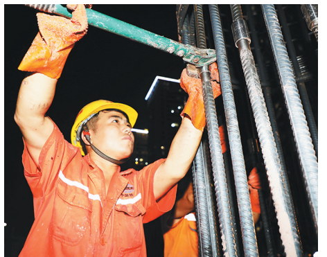
中铁十二局集团广州市轨道交通十八和二十二号线项目八分部面对施工任务重、工期压力大、周边管线复杂等困难,在确保安全质量可控的前提下,加快施工进度,三个工区掀起大干高潮。□刘国占 陈锋 摄
