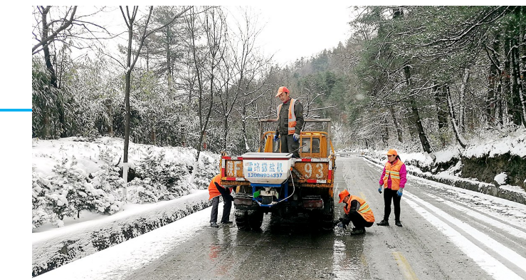
↑11月24日,汉中迎来入冬以来第一场雪,108国道秦岭段积雪达15公分,使道路严重阻塞。对此,汉中公路局佛坪公路段迅速组织职工全力以赴铲雪,确保公路安全畅通。
