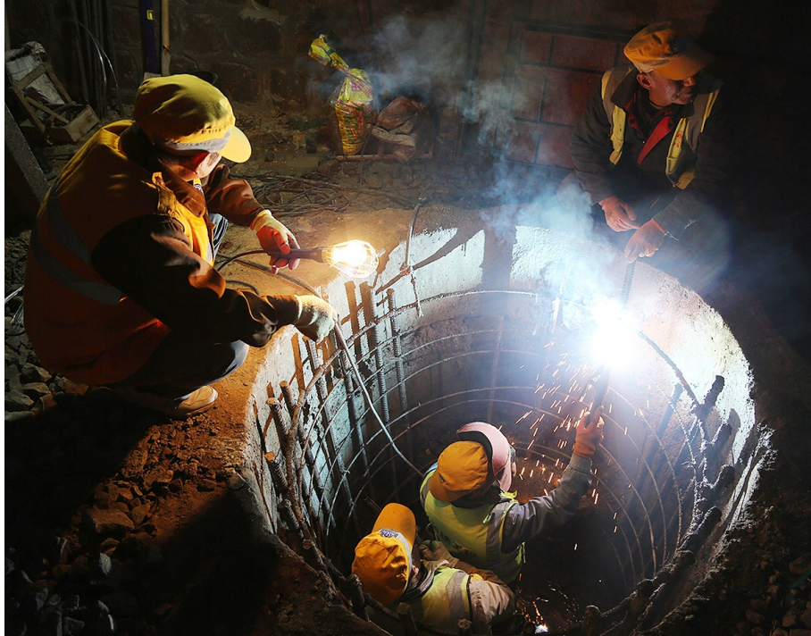
中国铁路西安局集团有限公司西铁工程公司针对低温季节性天气特点,进一步完善施工作业和人身安全保障机制建设,筑牢冬季施工安全防线。图为2019年12月30日,西安经九路下穿陇海铁路立交施工现场,该公司职工正在进行桩基开挖作业。 □田家卫 摄
