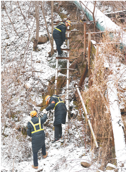
→ 一月七日，青石崖车站的员工在爬梯疏通山间饮用水管道。这里最苦的是用水，所有的生活用水都是天然蓄水获取。
