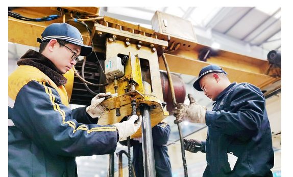
连日来,中国铁路西安局集团有限公司西安东车辆段以实际行动提前叫响“打造红旗设备 争当春运先锋”口号,组织人员对管内投伤机、起重车、车钩车床等100余台关键设备设施进行全覆盖检查整修,为春运车辆运输安全提供保障。杜朝辉 范锐 摄
