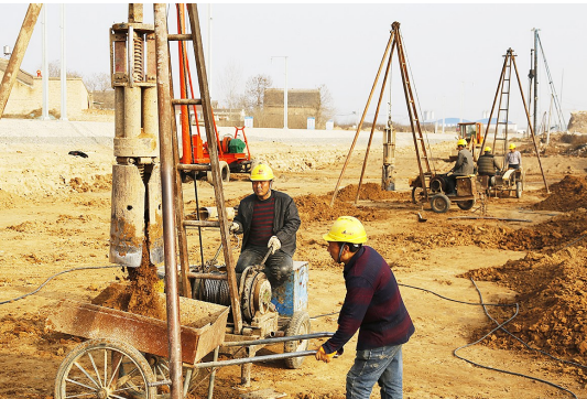
新年伊始,在咸阳市乾县新建城际铁路机场至法门寺线施工现场,中铁电气化局铁路工程公司施工人员进行接入银西高铁接轨段进行路基地基加固,这标志着新建城际铁路机场法接入银西高铁乾县接轨段工程正式开工。
