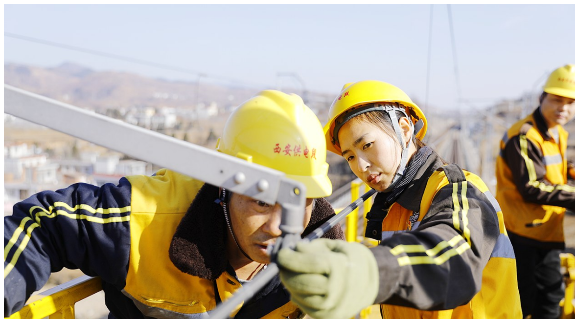
春运开始后,中国铁路西安局集团有限公司西安供电段工作人员利用春节前夕黄金时间,集中力量加强供电设备检修,确保春运期间供电安全。图为该段商洛供电车间接触网工正在高空检修接触网供电设备。 程如远 摄
