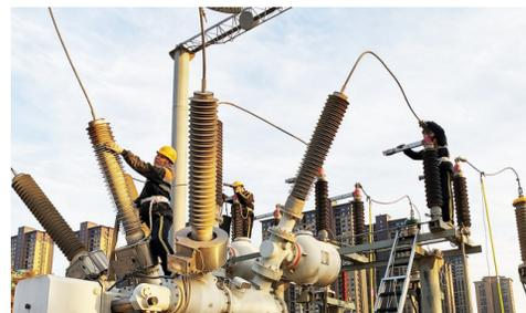
↑近日,在西安北电气化铁路牵引变电所,中国铁路西安局集团有限公司高铁基础设施段,组织职工对变压器等供电系统设备进行停电检修及预防性试验,确保春运铁路运输安全畅通。图为职工对供电设备进行检修。 倪树斌 李朝阳 田庆 摄
