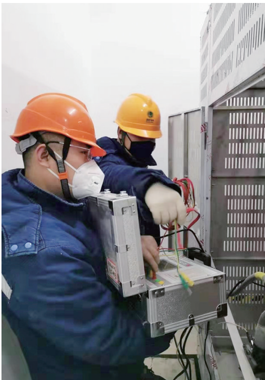
为做好疫情防控,确保医院电力供应,国网西安供电公司经过三天连续奋战,于1月28日完成西安市中心医院供电项目,为全市疫情防控工作正常开展提供坚强电力保障。 刘瑾 摄
