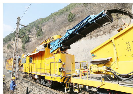
中国铁路西安局集团有限公司宝鸡工务段把守着西安局的西大门,自2月23日起至4月7日,该段全力组织开展陇海线、西平线集中修施工,打通“大动脉”,畅通“微循环”。图为该段在陇海线宝天段进行线路机械清筛施工。 彭刚 摄
