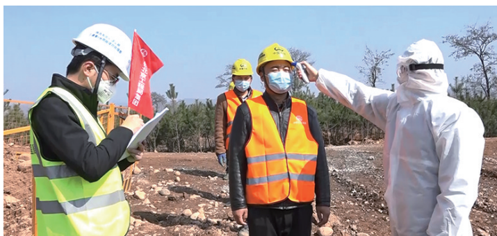
中铁北京工程局一公司在承建的旬(邑)至凤(翔)高速公路土建7、8、9标项目,积极开展疫情防控工作,确保防疫、复工两不误。图为一线建设者测量体温。 李杰 摄
