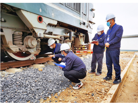
近日,中铁一局新运公司研和铺架基地,针对员工陆续返岗、复工复产在即等情况,对基地的机械设备进行检查,确保职工复工后施工和运输生产安全。图为职工正在检查大型设备。 □刘顺良 摄
